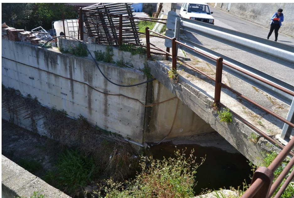
Figura 11. Sbocco canale tombato a valle, Via Arborea.
